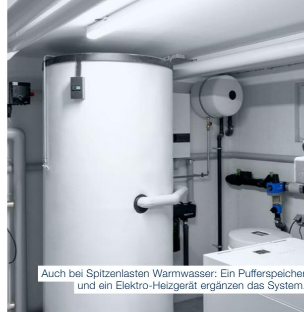
Auch bei Spitzenlasten Warmwasser: Ein Pufferspeicher und ein Elektro-Heizgerät ergänzen das System.
