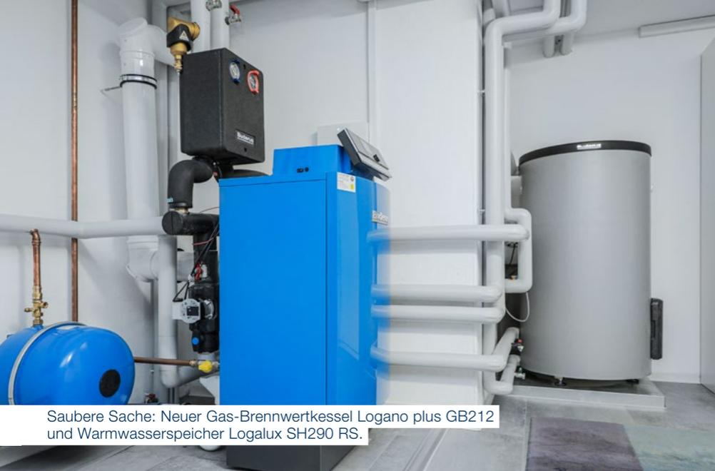
Saubere Sache: Neuer Gas-Brennwertkessel Logano plus GB212 und Warmwasserspeicher Logalux SH290 RS.
